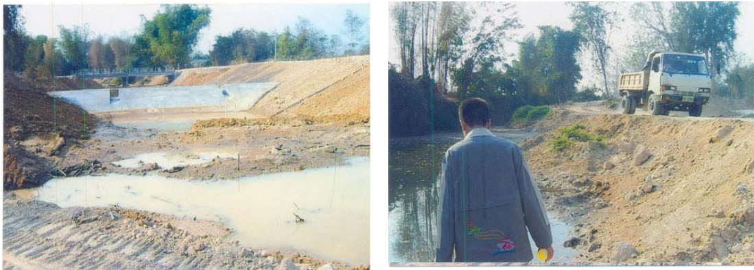
ภาพ 1 การสร้างถนน และทำสะพานรูกกล้าเข้าไปในลำน้ำแม่สาร
